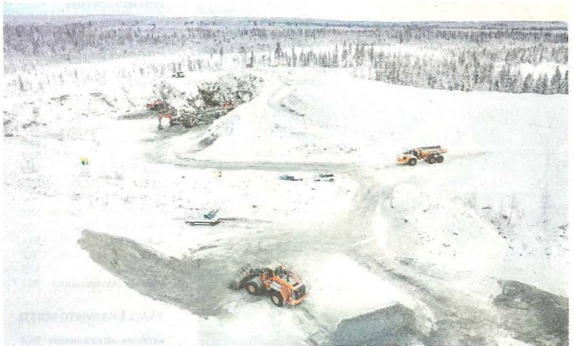
Suhangon kaivostietä rakennetaan. Kuva on joulukuulta.
